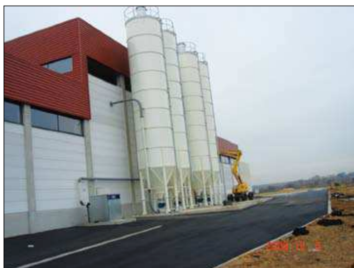
Voici le point de départ de la fabrication avec un total de 8 silos chacun d'une capacité de 85 tonnes accueillant entre autres les poudres de carbonate
